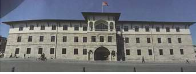
Foto 2. Sivas Hükümet Konağı (M.Bulut)
