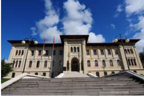
Foto 4. Kastamonu Hükümet Konağı
