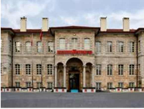
Foto 3. Konya Hükümet Konağı
