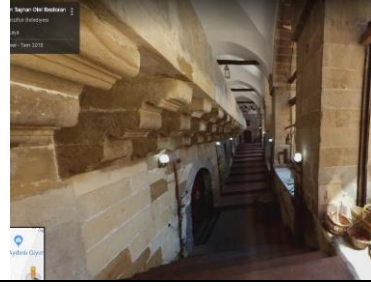
Bodrum katın üstündeki konsol çıkma
