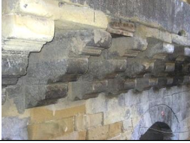
Bodrum katın üstündeki konsol çıkma
