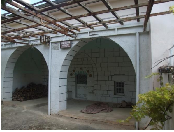
Resim 2) Kadı İbrahim Köyü Camii kuzey cephesi
