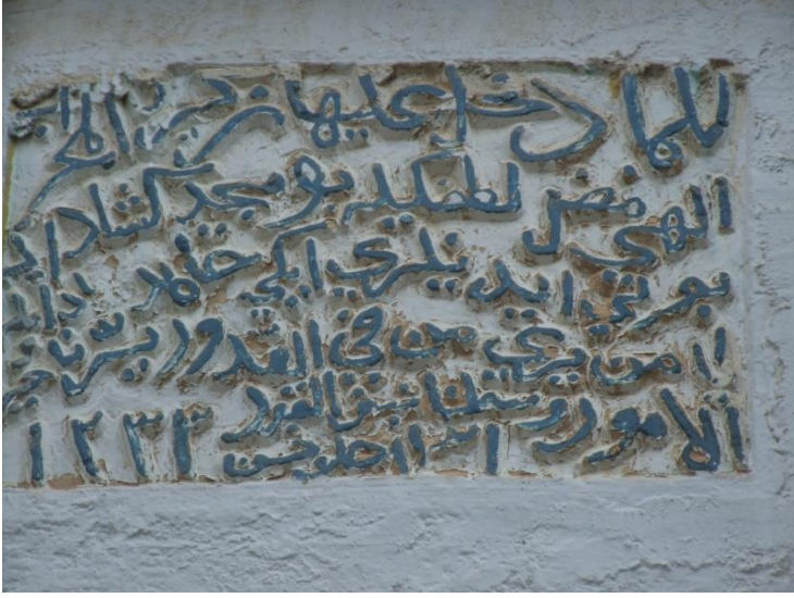
Resim 12) Kadı İbrahim Köyü Camii son cemaat mahali cephesindeki onarım kitabesi
