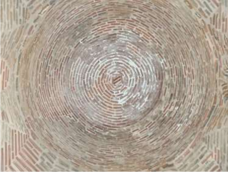
Görsel 19. Erenler Türbesi, kubbe
