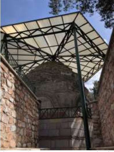
Görsel 2. Burgaç Hatun Türbesi, restorasyon sonrası durumu
