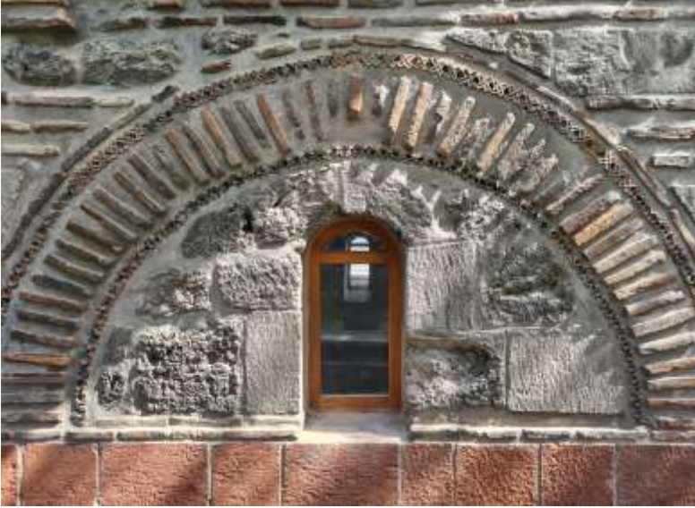
Görsel 6. Burgaç Hatun Türbesi, cephedeki sağır kemerler ve yonca biçimli pişmiş toprak süslemeler
